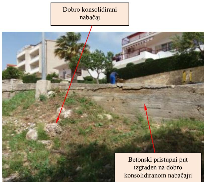
Slika br. 19 – Dobro konsolidirani nabačaj na kojem je izgrađen betonski pristupni put
